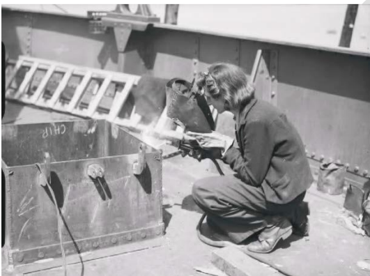
شکل ۳۴ - جوشکار متخصص، خانم Sadie Nairn، در حال کار بر روی یک کشتی مین روب در کارخانه کشتی سازی Greenock، اسکاتلند. مجموعه های موزه های جنگ امپراتوری، ۱۹۳۹
