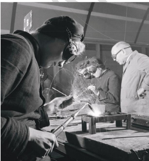
شکل ۳۵ - اعضای سرویس نیروی دریایی سلطنتی زنان (WRNS) به عنوان بخشی از آموزش خود برای تبدیل شدن به مکانیک کشتی در سال ۱۹۴۳، جوشکاری را در یک مرکز آموزشی دولتی تمرین می کنند. جرقه ها به پرواز در می آیند که زنان WRNS یاد می گیرند که از مشعل های اکسی استیلن در کارگاه جوشکاری استفاده کنند. مرکز آموزش دولتی (احتمالا اسلاو)، به عنوان بخشی از آموزش آنها برای تبدیل شدن به مکانیک کشتی (LC). با نظارت مربی خود، آنها در حال یادگیری کنترل زاویه مشعل و تصحیح زاویه سیم در هنگام ساخت قطعات T-section هستند. مجموعه های موزه های جنگ امپراتوری، بریتانیا.
