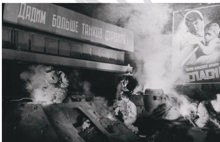
شکل ۲۶ - زنان در حال جوش دادن قطعات بدنه اسلحه های خودکشی SU-100 و SU-122 در کارخانه مهندسی سنگین اورال، ۱۹۴۲. جالب است که به مانیفست تبلیغاتی جنگ توجه کنید. منبع: waralbum.ru.
