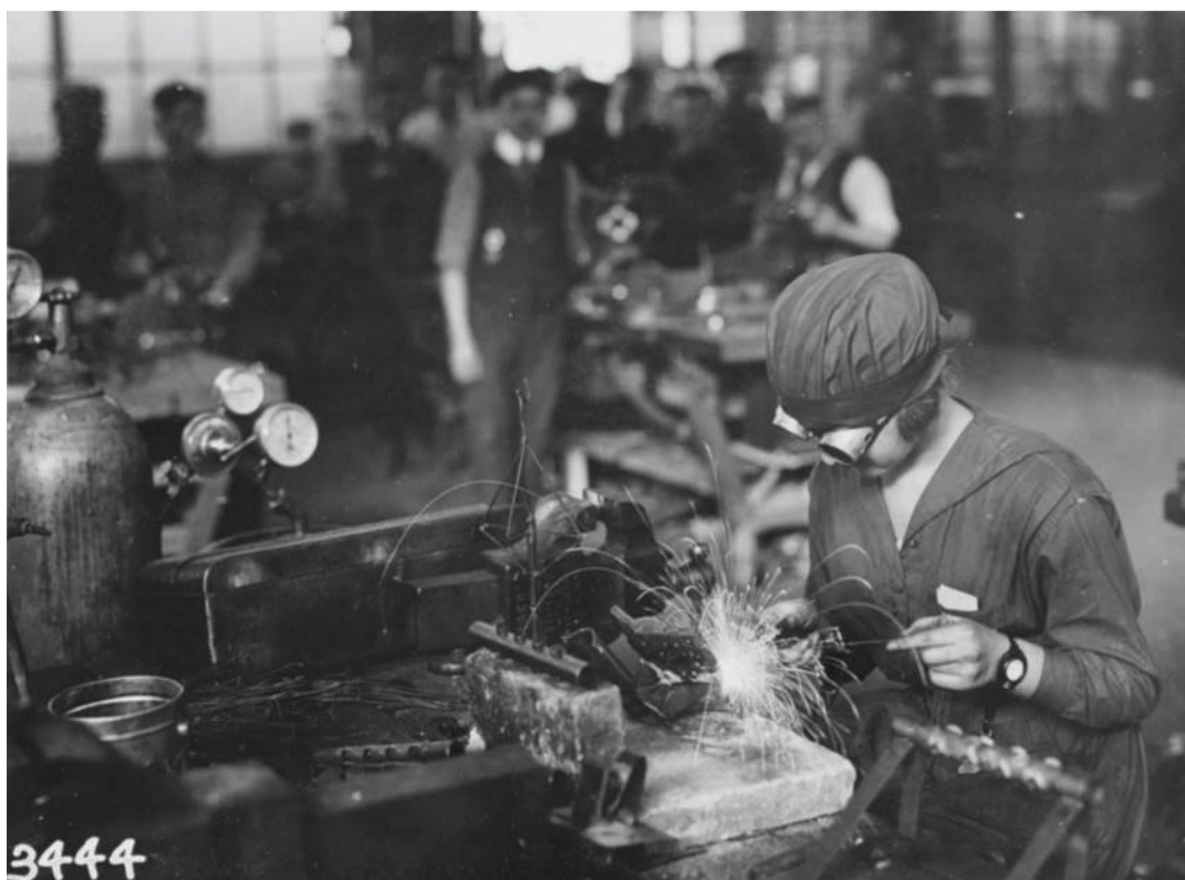
شکل ۸ - زن جوشکار اکسی استیلن در هواپیمای نیروی دریایی در فیلادلفیا، پنسیلوانیا، ۱۹۱۸. فرماندهی تاریخ و میراث نیروی دریایی ایالات متحده.
