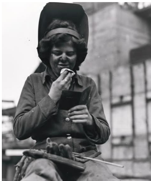
شکل ۲۵ - دوروتی، یک زن جوشکار در حال تمیز کردن صورت خود در حین کار در پل واترلو، در سال ۱۹۴۴. یکی از حدود ۲۵۰۰۰ زن که در اواخر جنگ جهانی دوم در ساختمان سازی کار می کردند، پل واترلو، لندن، ۱۹۴۱. آرشیو روزانه هرالد - ملی موزه علوم و رسانه - کتابخانه تصویر علم و جامعه.
